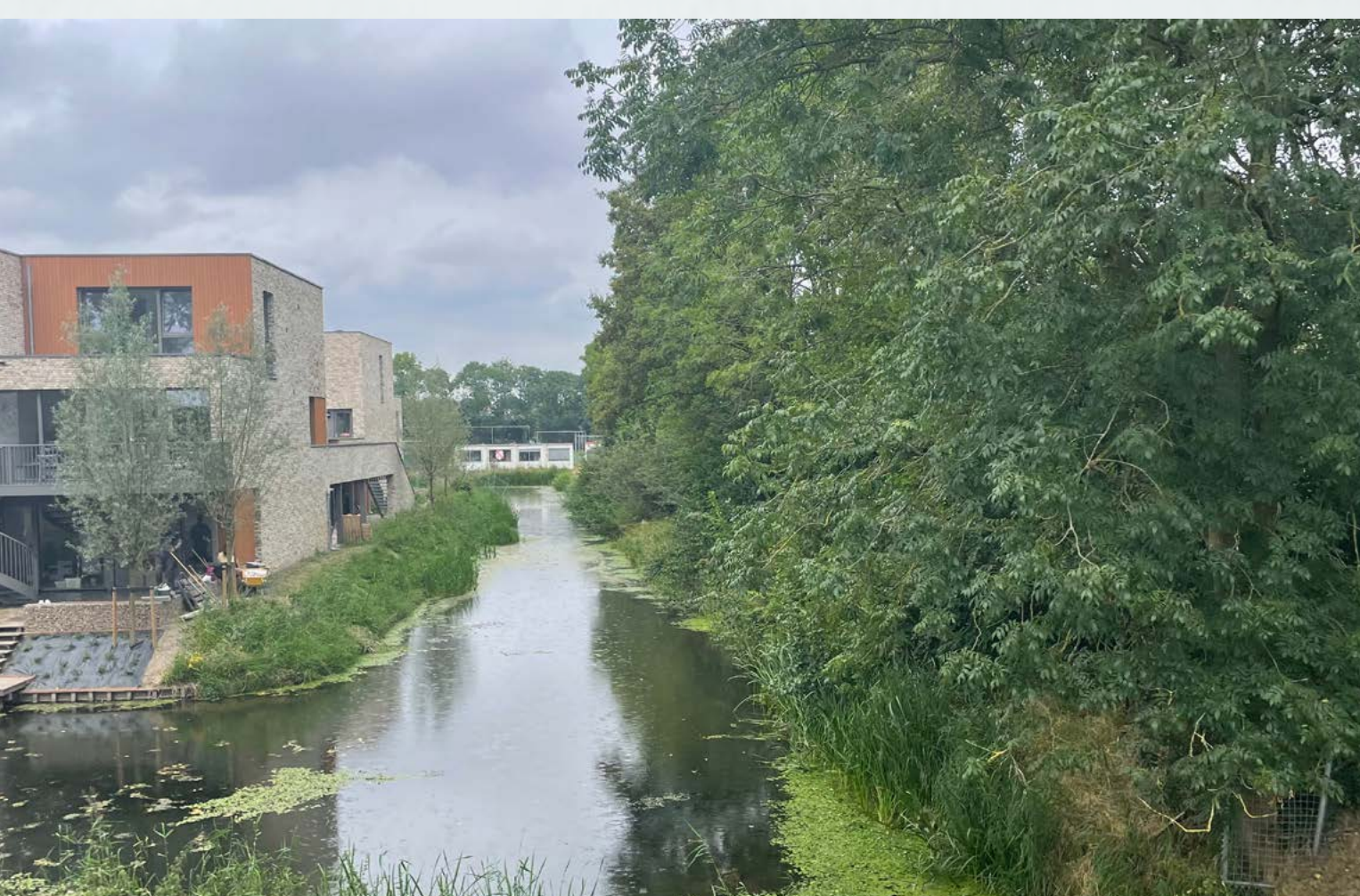
Aantakken op bestaande watergangen
